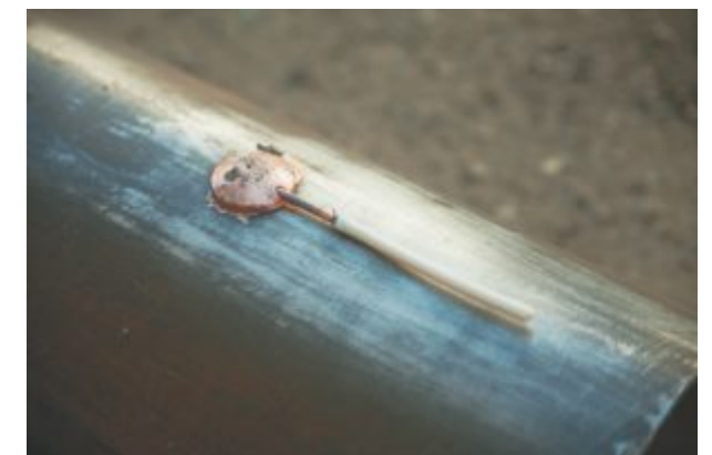
Готовая приварка
