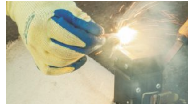
Процесс поджига термитной смеси термитной спичкой. В случае с термокарандашом используется другой источник открытого огня (спичка, зажигалка).
