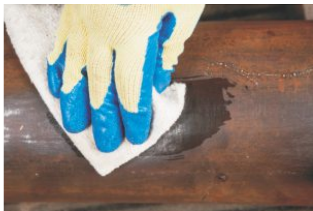
Обезжиривание поверхности трубы
