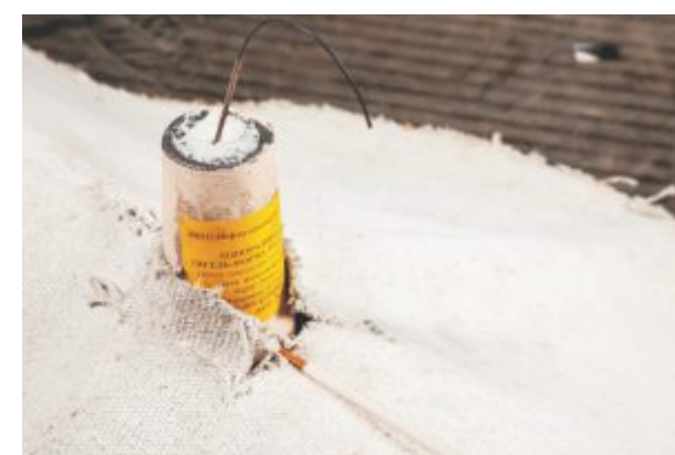
Установка одногранной тигель-формы
