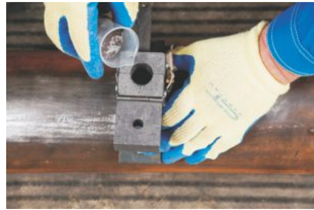
Засыпка порции термитной смеси в многогранную тигель-форму
