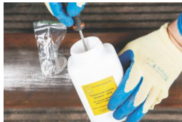
Перемешивание термитной смеси
