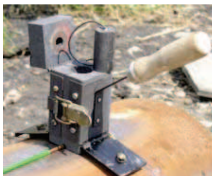
Фото 4. МТФ и термокарандаш на трубе 1400 мм
