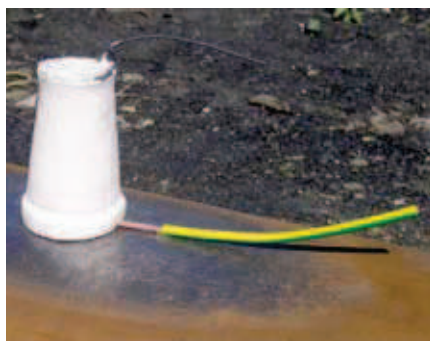
Фото 3. РТФ-НГК установлена с выводом на трубе
